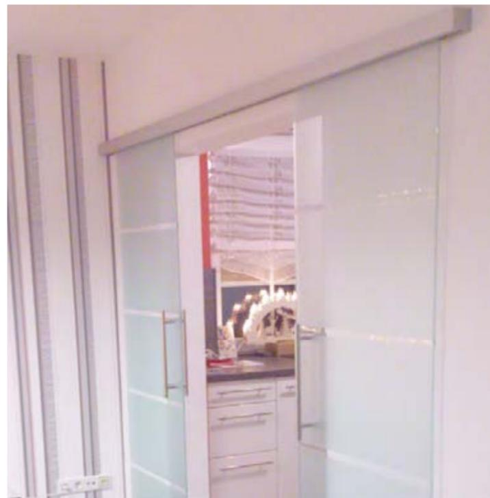
Schiebetürbeschlag Opti 80 - 2 Flügel geschlossener Schiebetürbeschlag mit 2 Türen, Einzugsdämpfung beidseitig, Oberfläche EV1 oder Edelstahleffekt, Griffstangen
